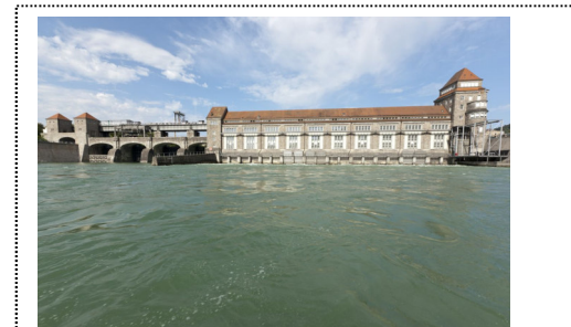
Wasserkraftwerk Laufenburg (Bild: Energiedienst / Roland Horn)
