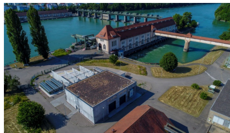
Power-to-Gas-Anlage in Grenzach-Wyhlen (Bild: Energiedienst / Werbefabrik)
