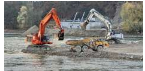
Beispiel 3: Felsabtrag über Vorschüttungen, Neubau KW Rheinfelden
