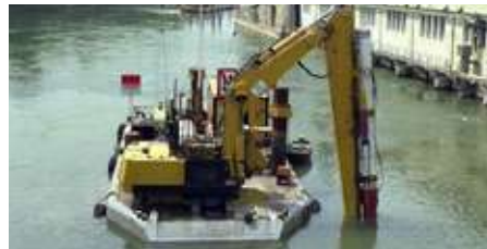
Beispiel 2: Felsabtrag durch Meißeln, KW Augst/Wyhlen
