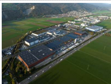
Photovoltaikanlage Migros-Verteilbetrieb Neuendorf AG (Bild: Energiedienst / Günter Bolzern)
