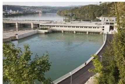
Wasserkraftwerk Rheinfelden (Bild: Energiedienst / Roland Horn)
