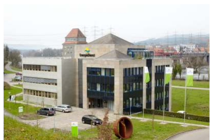
Sitz der Energiedienst Holding AG in Laufenburg, Schweiz (Bild: Energiedienst / Christoph Fein)
