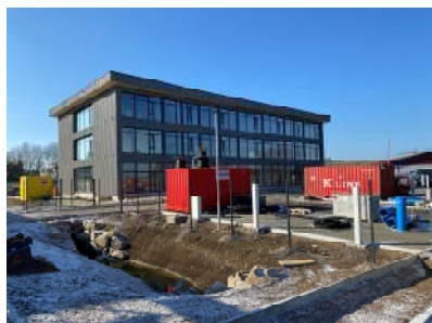
Neubau ED Netze GmbH in Donaueschingen (Bild: Energiedienst)
