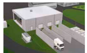
Die Anlage mit Speicher und Abfüllstation.
