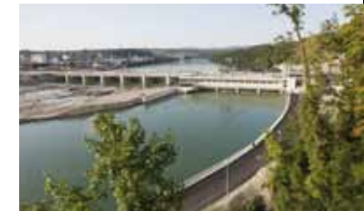
Neues Wasserkraftwerk Rheinfelden
