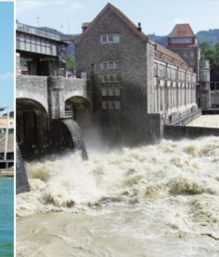
Das Wehr kann ein Hochwasser von bis zu 5.200 Kubikmetern pro Sekunde sicher abführen.
