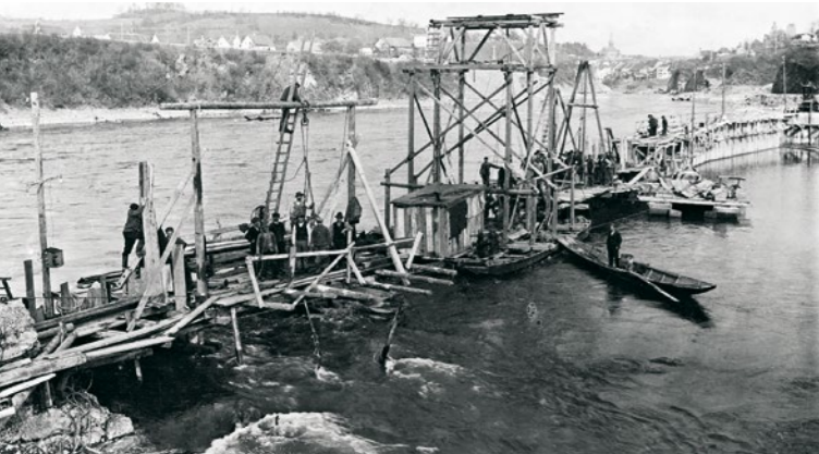
Mehr als 1.200 Bauarbeiter waren in Hochzeiten gleichzeitig auf der Baustelle beschäftigt.
