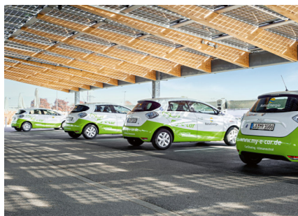
Photovoltaik-Carport in Rheinfeldern (Bild: Energiedienst / Daniel Infanger)
