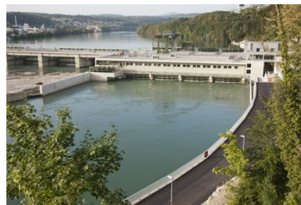
Wasserkraftwerk Rheinfelden (Bild: Energiedienst / Roland Horn)
