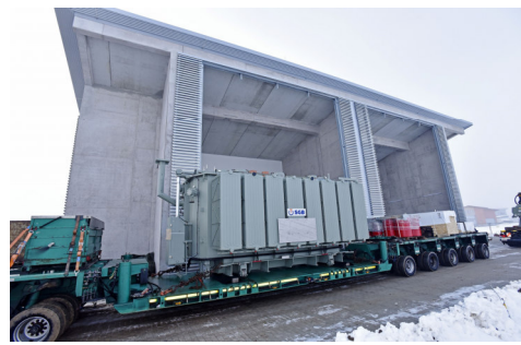
Neues Umspannwerk Löffingen, Anlieferung 110- kV-Transformator (Bild: Energiedienst / Roland Sigwart)
