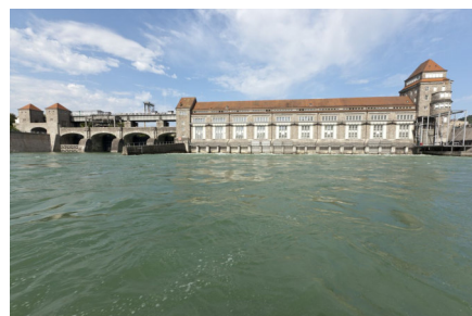
Wasserkraftwerk Laufenburg (Bild: Energiedienst / Roland Horn)
