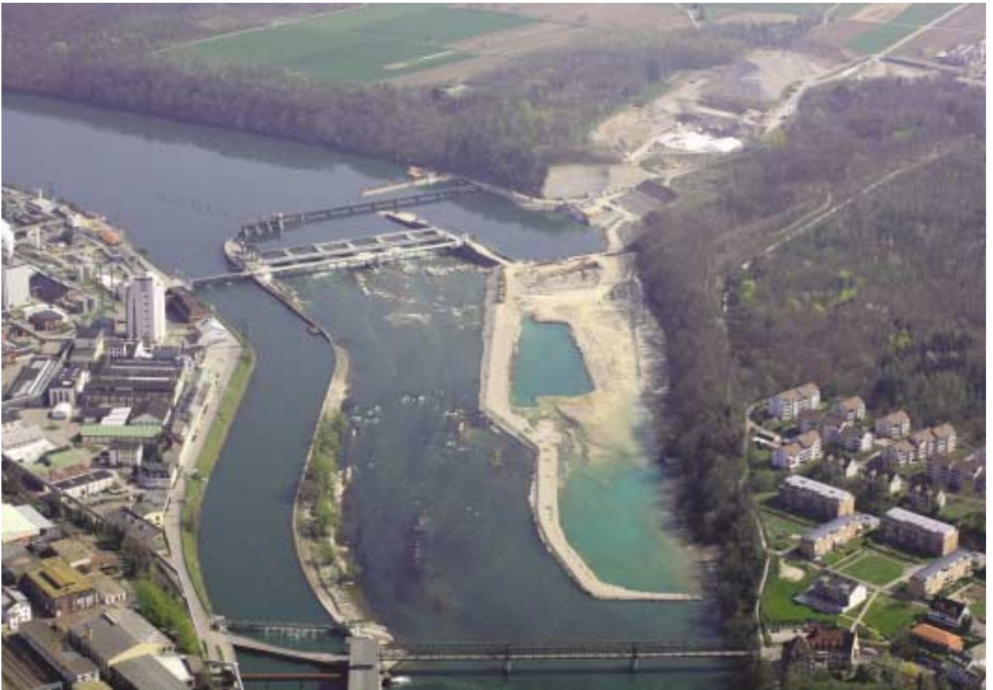
Neubau Kraftwerk Rheinfelden, Mai 2007
