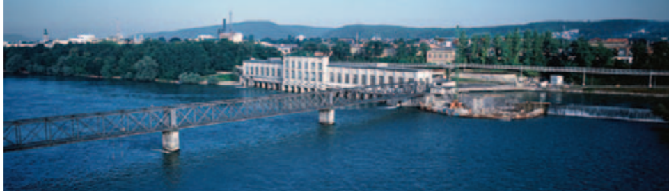
Blick auf das alte Kraftwerk Rheinfelden.
