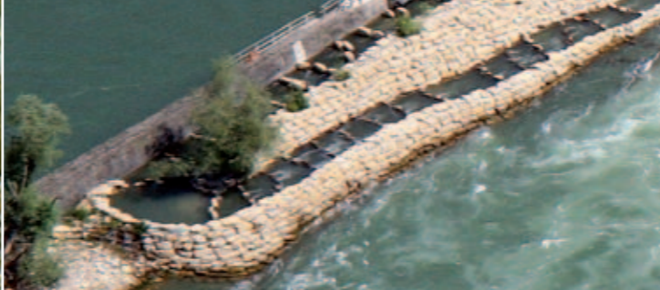
Fischpass am Stauwehr.
