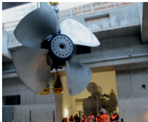
Das Laufwerk wiegt 60 Tonnen und wurde in einem Stück angeliefert.
