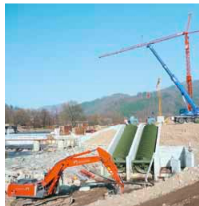
Ein Schwerlastkran hob die 55 Tonnen schweren Wasserkraftschnecken Anfang Februar ein.
