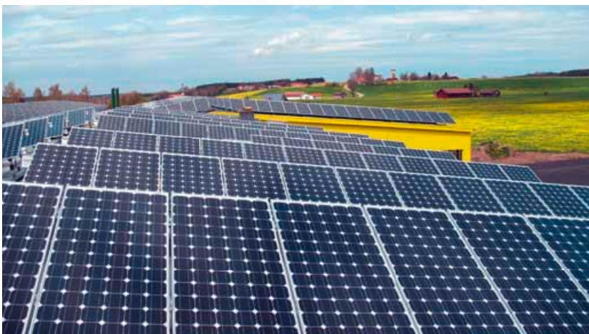
Die Dächer sämtlicher RAPUNZEL-Firmengebäude sind mit Fotovoltaikmodulen bestückt.
