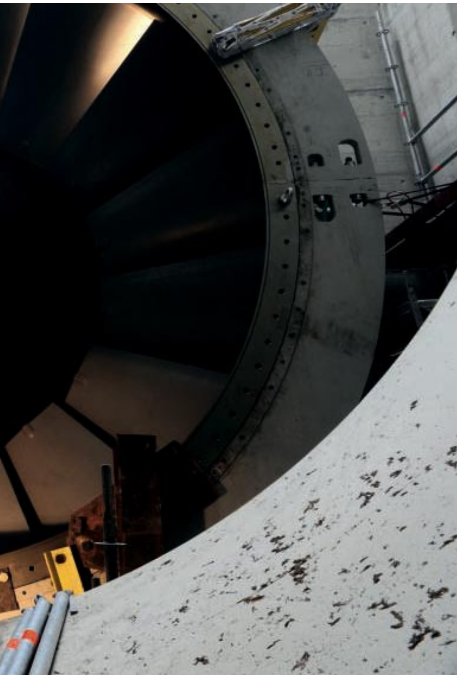
Das Laufrad wiegt 60 Tonnen und wurde in einem Stück angeliefert.
