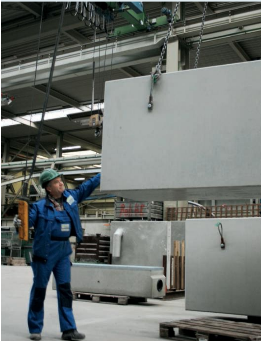
Bei der Herstellung der Betonfertigteile wird bei Mall auch der Umweltaspekt berücksichtigt.
